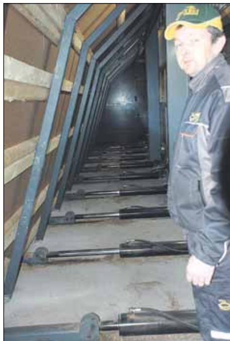
Energiaosuuskunnan toiminnanjohtaja Bernt Svens esitteli, miten hydrauliset tankopurkaimet työntävät haketta kolikuljettimille ja edelleen polttokattilaan.
