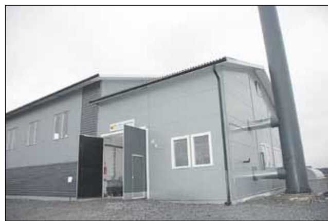
Vöyrin Energiaosuuskunnan rakentama hakelämpökeskus on noussut Lämpöraitti 5:n tontille.
