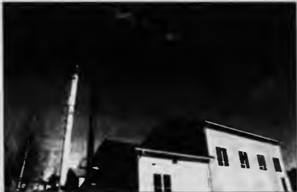
Flisvärmecentralens yttre stod klart i somras, och sedan den 10 oktober ryker det ur skorstenen. Foto: Mikael Herrgård
