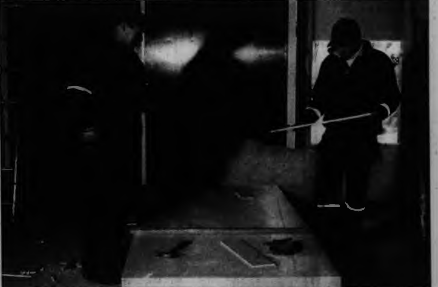
Per-Erik Granfors och Kaj Rex i Västra energiandelslag bygger själva fliscentralen i Maxmo på ett tomt som kommunen arrenderat ut. Och de bygger stort med tanke på framtida modifieringar. Foto: Stig Svens
